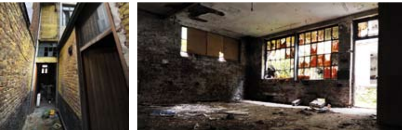
La taille du périmètre urbain réhabilité (îlot) est suffisant pour créer un effet d'entraînement dans le quartier.
